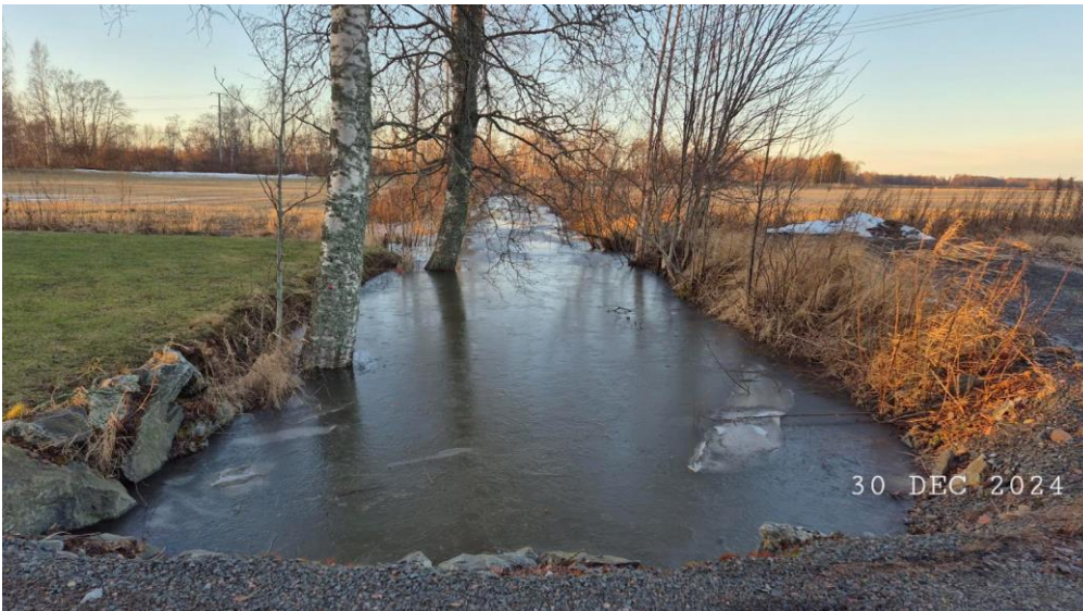
Kuva 13 Oja päästettynä täyttymään 30.12.24 vastaavasti, kuin 28.11.24 oli.
